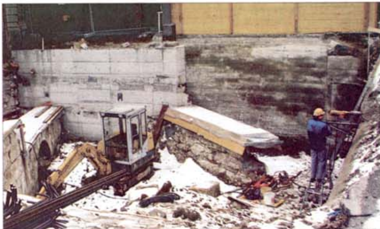
Die Wand zur Unterführung (rechts) wird angebohrt. Reste der Stadtbefestigung (links) bleiben bestehen.
